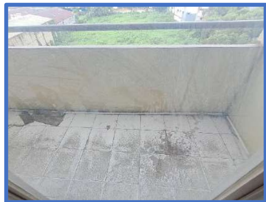
Tampak Balkon Unit Apartemen
